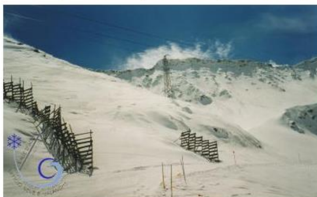
Ponti da neve posti a monte della pista da sci. Nell'aparte alta della fotografia si vede la zona di idstacco della valanga 60.
