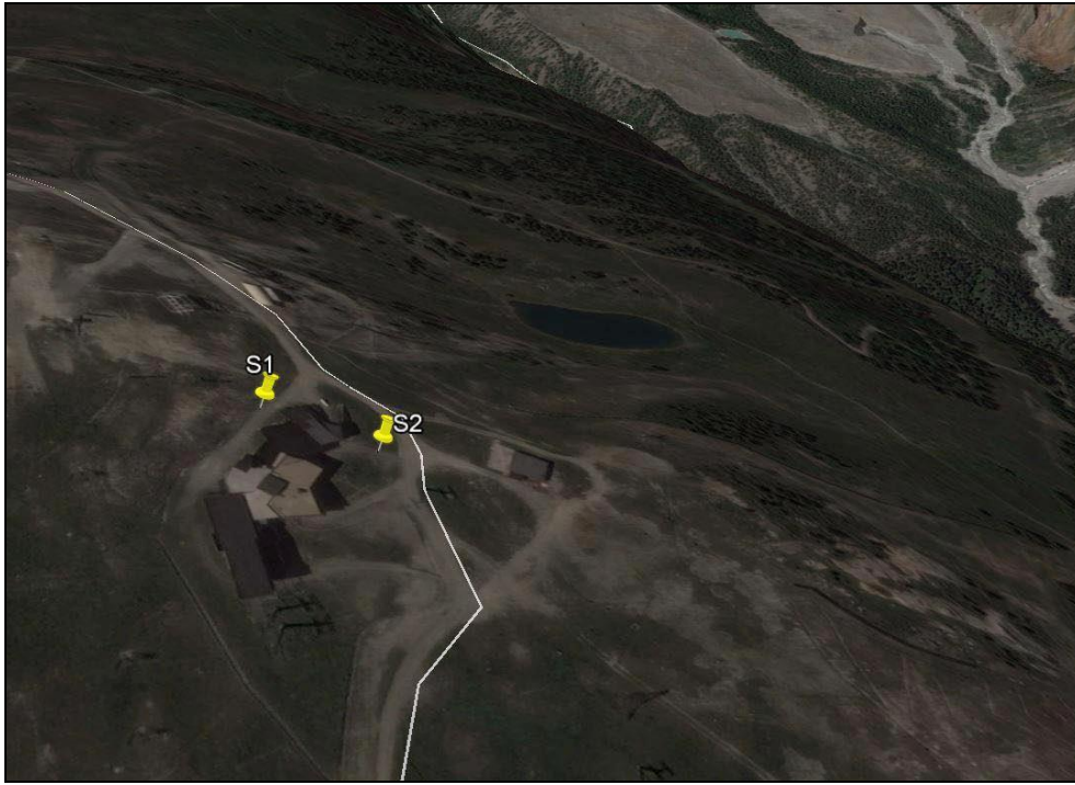
Esecuzione di indagini geognostiche Comune di Courmayeur - Nuova Funivia Col Chécrouit-Arp
