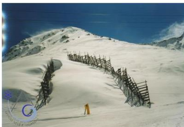
Ponti da neve posti a monte della pista da sci. Nell'aparte alta della fotografia si vede la zona di idstacco della valanga 62.
