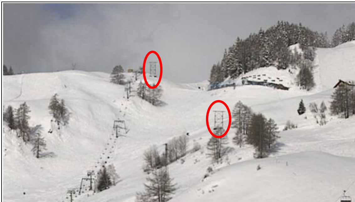
Fotografia con evidenziati due sostegni della linea elettrica da smantellare
